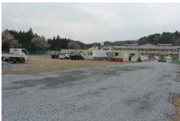
校庭に仮設住宅を建設中。
