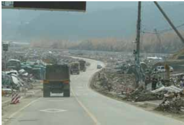
市街地へ入る道路からみる被災地。
